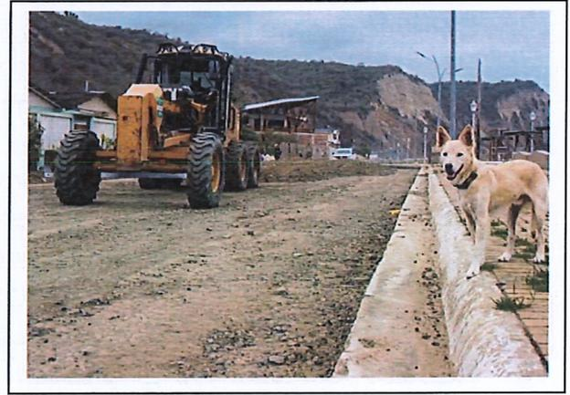
**Ilustración 15: CONSTRUCCIÓN A NIVEL DE D.T.S.B. Y CARPETA ASFÁLTICA DE 2" DE LA VÍA LA ALBORADA - LA RUTA DEL CHOCLO DEL CANTÓN PORTOVIEJO**
